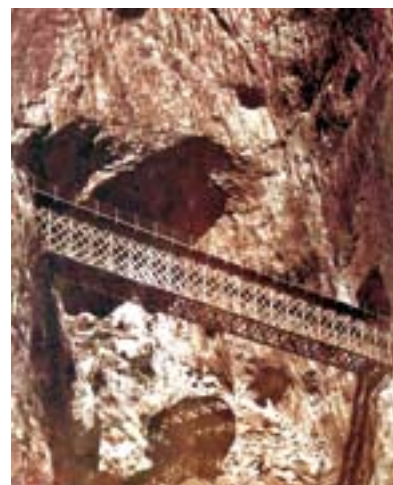
-Viaducto y túnel de la línea Córdoba-Málaga
