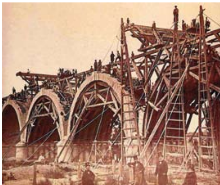
-Construcción del "Puente de los Franceses"
