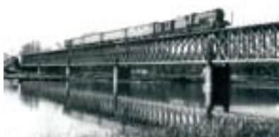
-Puente de "Pradillo"
