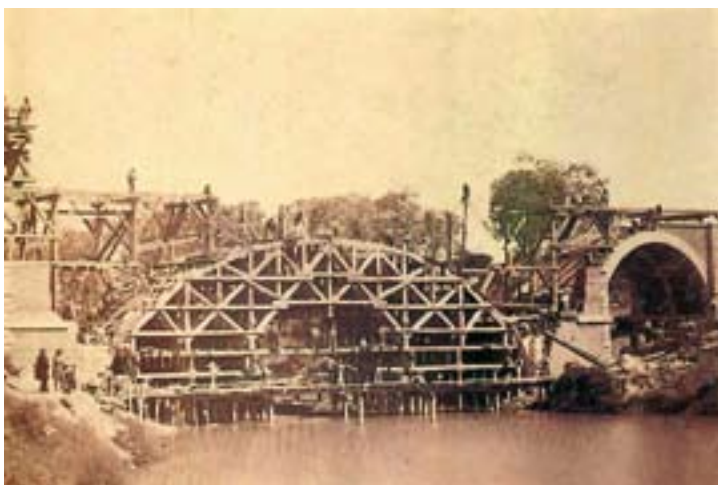
-Construcción de un viaducto sobre el Duero en 1860
